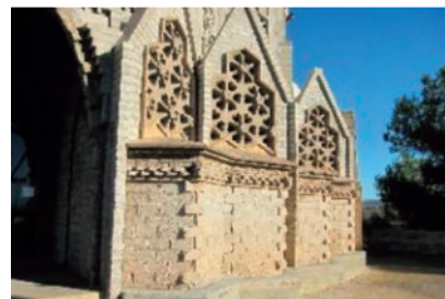
Fig.2) 再建されたゴシック・雁行ファサード 2000.
